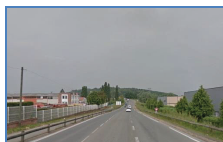
Photographie 8 : RD186 en direction de la RN20 en traverse de la zone d'activités (P8)
